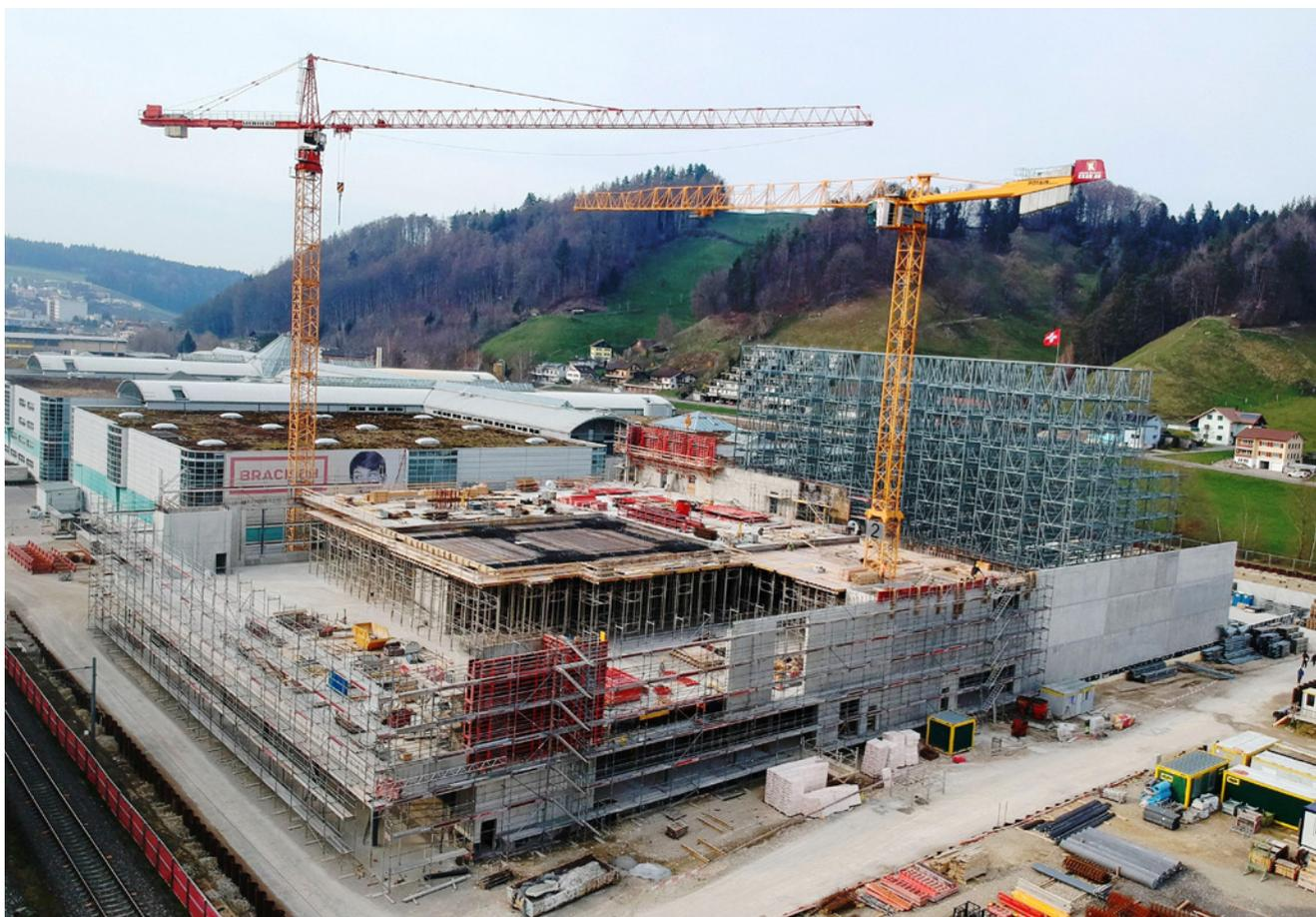
Der Bauherr Competec Logistik AG realisiert seit April 2019 einen Erweiterungsbau anschliessend an die bestehenden Logistikgebäude in Willisau. Auf einer Grundfläche von gegen 10'000 m<sup>2</sup>, mit einer Bauhöhe von 31 Metern, entsteht ein massiver Baukern aus Beton. An diesen angebaut, beziehungsweise teilweise darüber gelagert, werden zwei vollautomatische Hochregallager angedockt.
