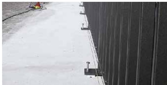
Innfesting av rekkverk
